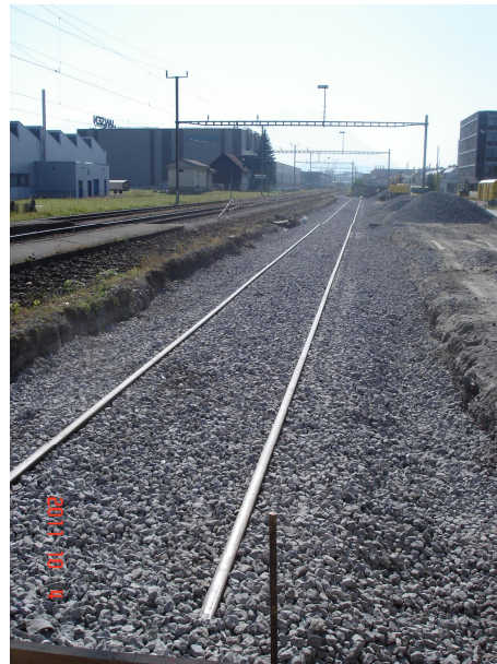
Neu verlegtes Gleis
