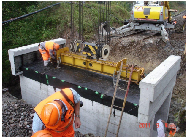
Einbau des vorfabrizierten Elements mit Schienenkran
