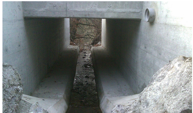
Bachdurchlass mit Niederwasserrinne
