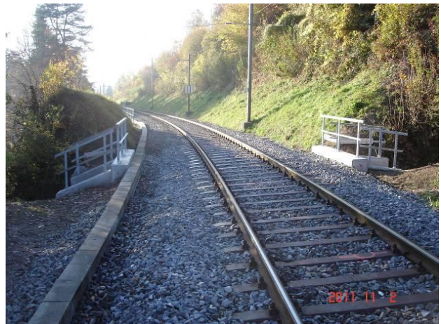
Bachdurchlass nach Fertigstellung
