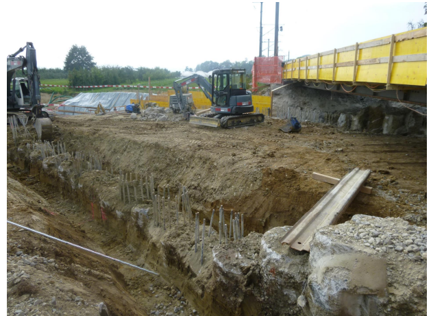
Überschnittene Bohrfahlwand / Hilfsbrücke
