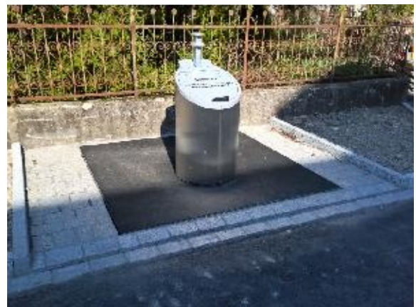
Unterflurcontainer in Betrieb
